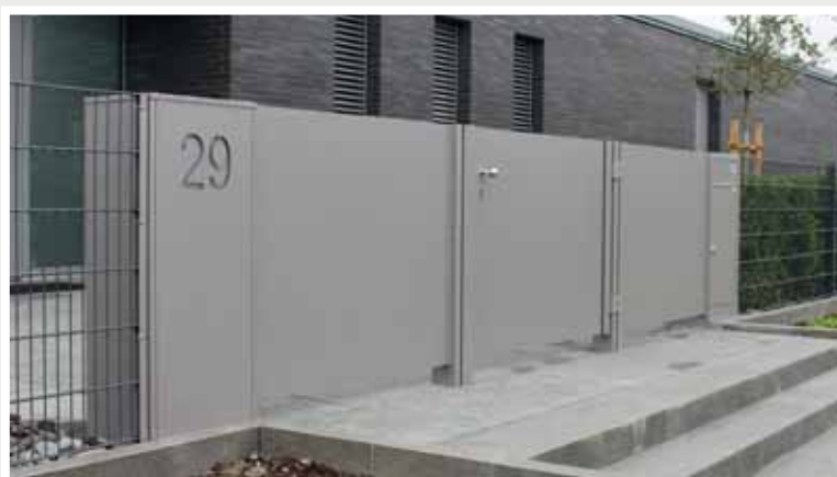
Gehür und „Zaunfeldanlage“, Briefkastensäule mit Paketbox, 1,26 m Höhe, Blech beidseitig über den Rahmen gesetzt, in DB 702 beschichtet
