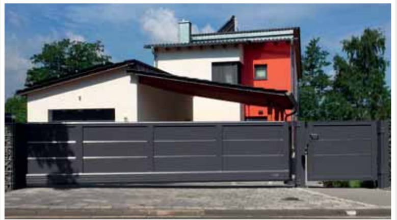
6 m Schiebetor, Glattblech mittig im Rahmen (Typ B1) mit Edelstahlstreifen, RAL 7016 Matt, Anschlusstür
