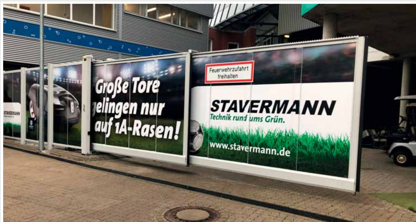
12 m Teleskopschiebetor, Höhe 2,5 m, Glattblech mittig im Rahmen (Typ B1) mit bedruckten Platten, Inline 250-T
