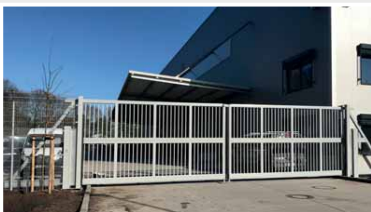
11 m Schiebetor als gegenläufige Anlage - 2 x 5,5 m, 3 m Höhe, Profil 30/30, RAL 9006 Seiden, Inline 120, 1,69% Schrägbau – in der Höhe 2-geteilt
