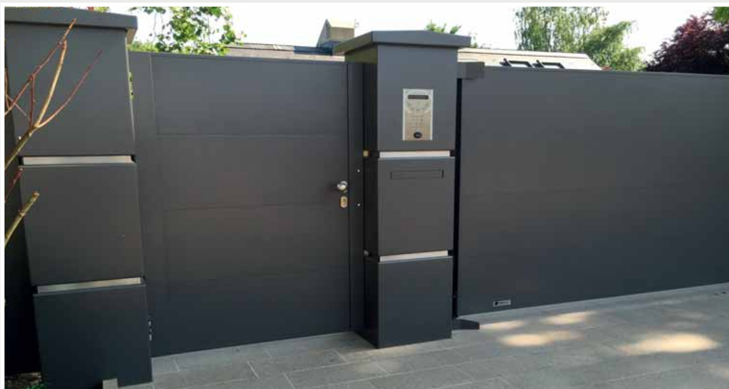
Sondersäulen 400 x 400 mm als Einlauf- und Haltepfosten mit flächenbündigem Briefeinwurf und GSM Sprechanlage
