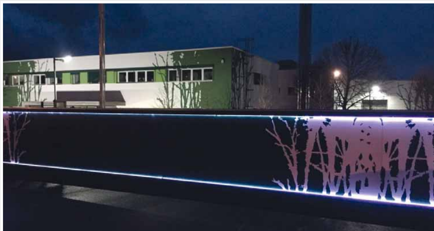
10,35 m Schiebetor, Glattblech im Rahmen und vor die Kämpfer gesetzt, mit bedruckter Folie und LED-Lichtleiste beleuchtet, RAL 6005 Matt, Inline 120
