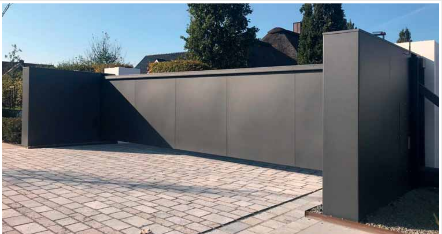
7 m Schiebetor, Glattblech beidseitig vor die Laufschiene (Typ B9) gesetzt, RAL 7016 Feinstruktur mit 2 m breiten Halte- und Einlaufpfosten als Sonderbau
