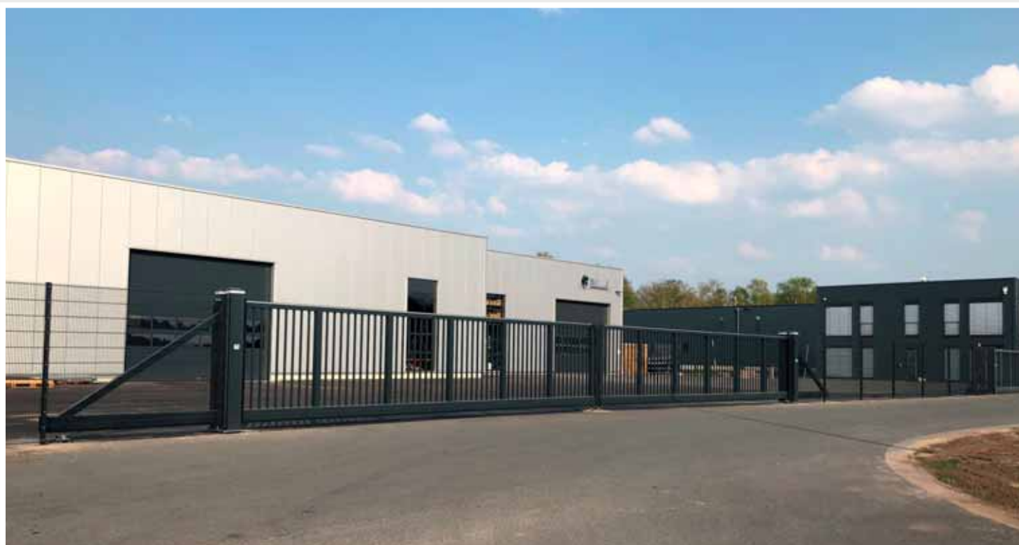
16 m Schiebetor als gegenläufige Anlage - 2 x 8 m, Profil 30/30, RAL 7016 Matt, Inline 250 Speed
