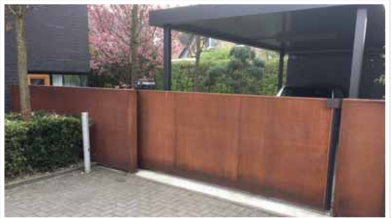
2,9 m bodengeführtes Schiebetor, Höhe 1,33 m, Füllung Corten-Stahl vor den Rahmen gesetzt, (Typ B8/B9)
