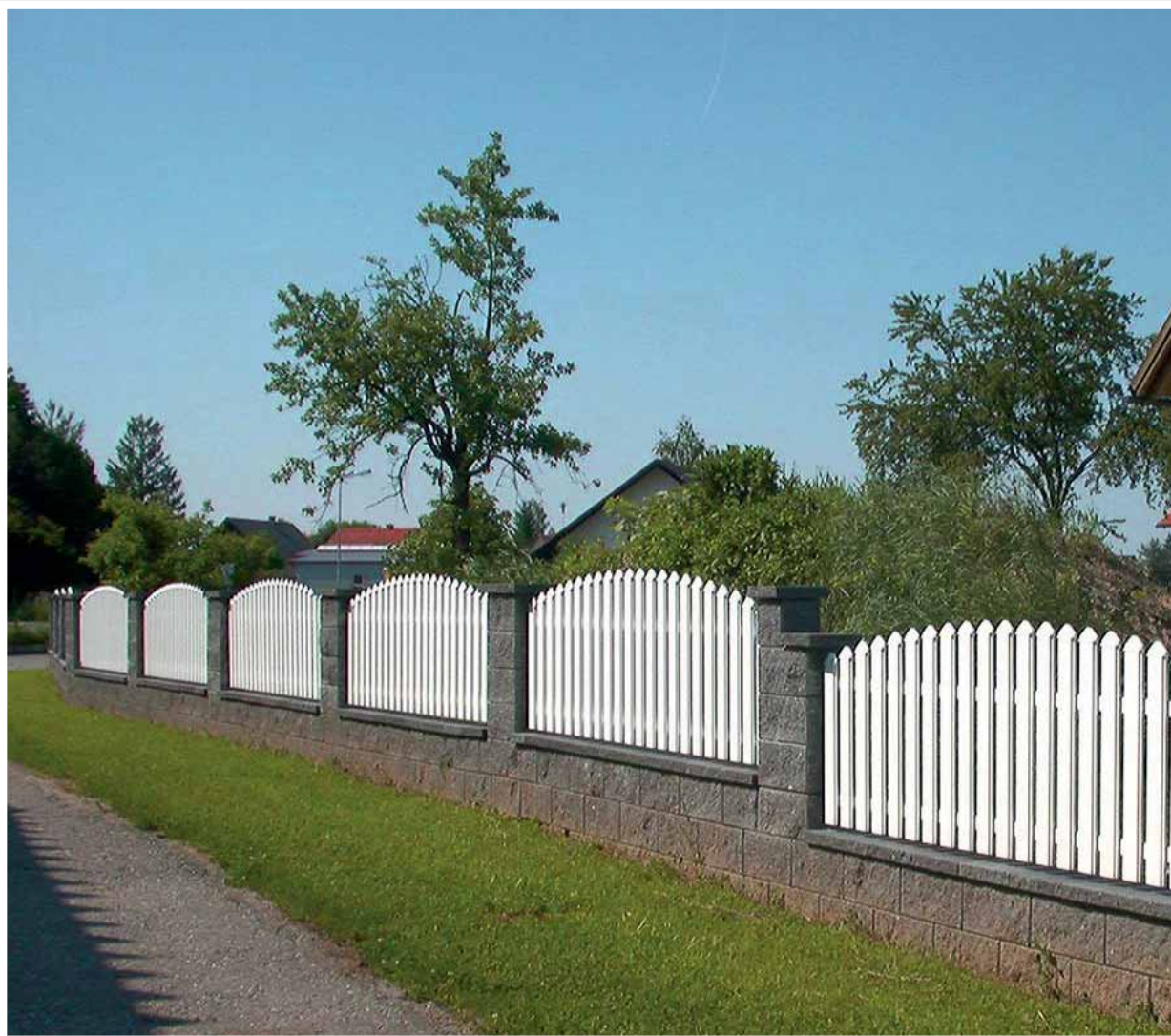
Zaunfelder, Salzburg Konvex mit Spitzkappe, Montage auf bauseitiger Mauer
