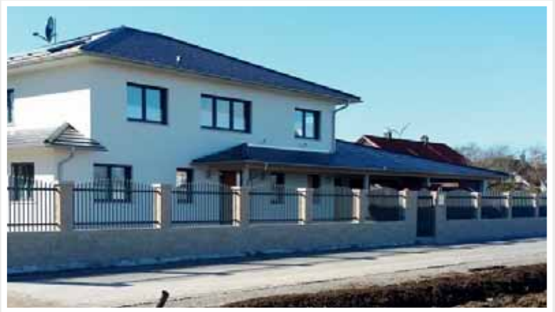
Zaunfelder Paris Konvex mit Spitzkappe, RAL 7012 Matt, montiert auf bauseitiger Mauer
